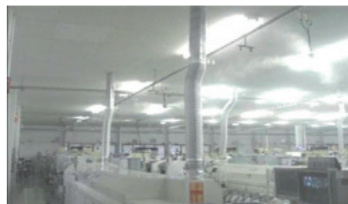
リフロー炉周辺
