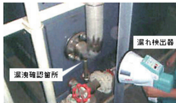
エア漏れ調査
